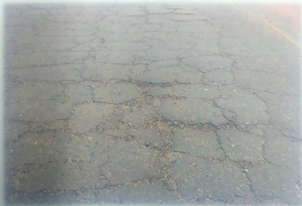
Foto N° 2 Fisuras estructurales
